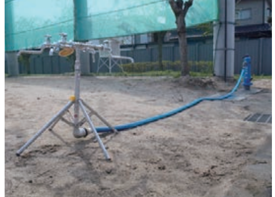
災害時給水栓開設時のイメージ
